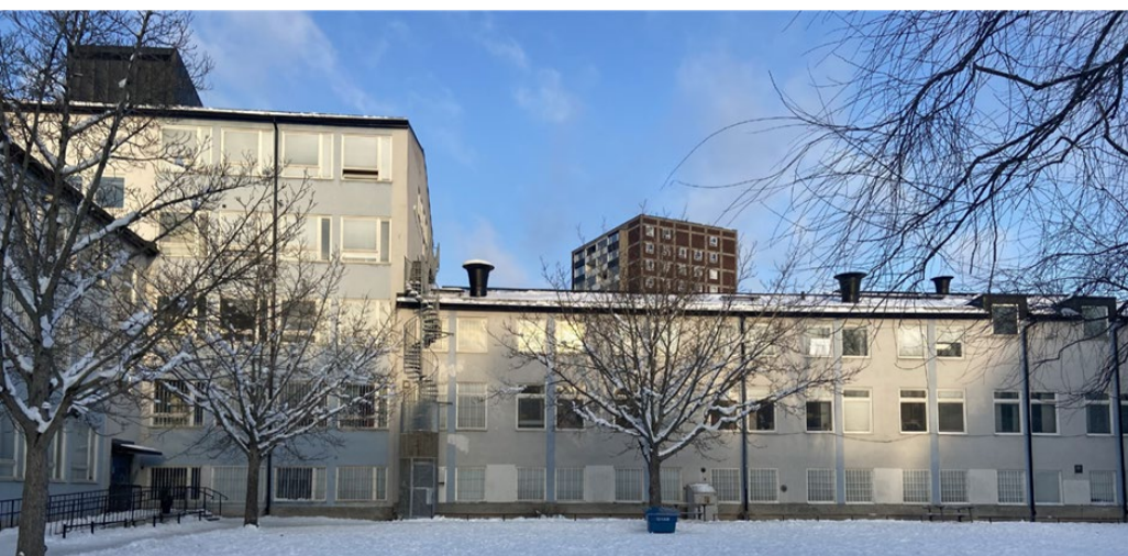
Hus C sett från skolgården. I Den högre av byggnaderna, hus C, finns det hisschakt som är platsen för konstprojektet. I hus C ligger aulan, specialsalar, administration och matsalen.
