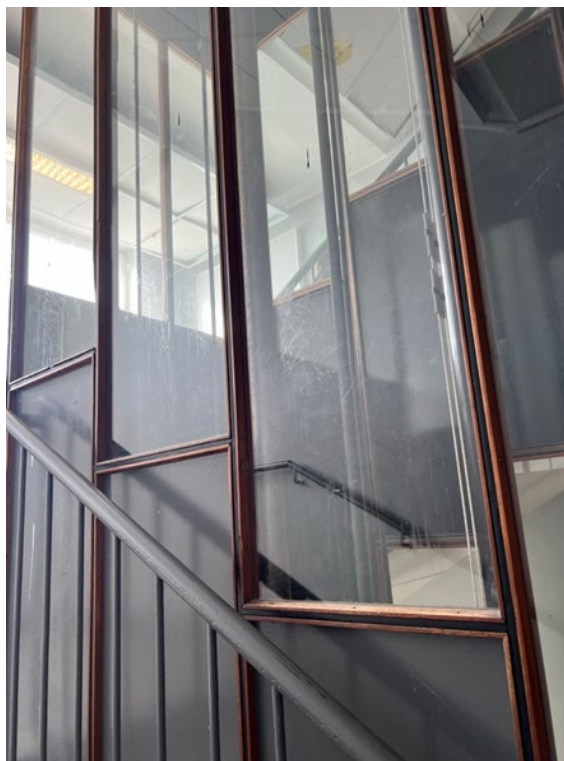
Hissen och hisschaktet.
