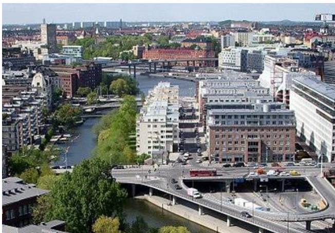
Parken sedd från söder, mellan vattenspegel och vit husrad.
