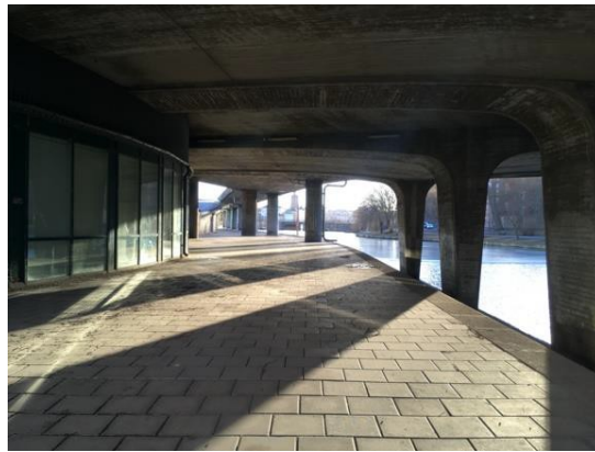
Vy mot den angränsande undersidan av Klarabergsviadukten.
