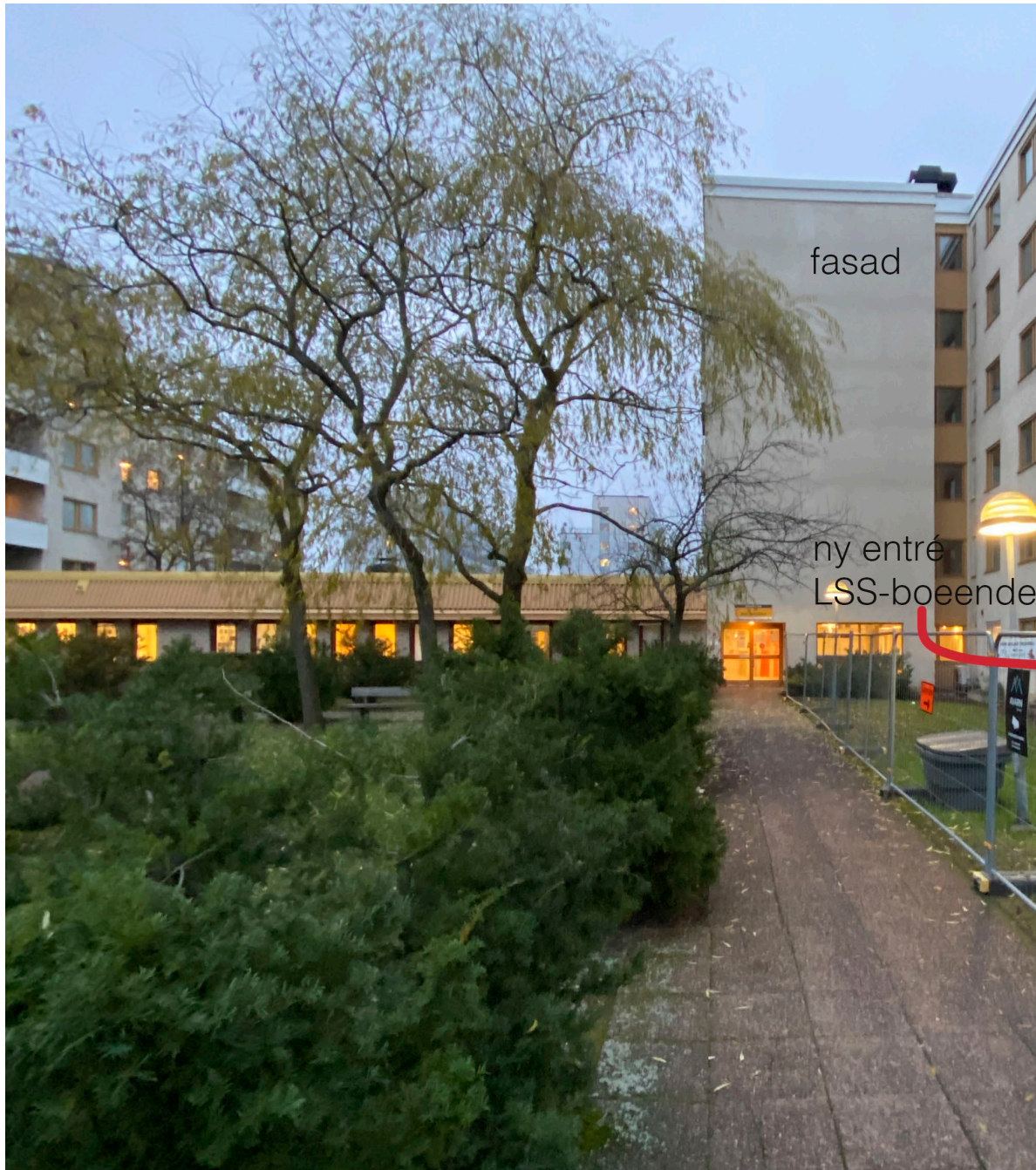
Fasaden sedd från Köpenhamngatan.
