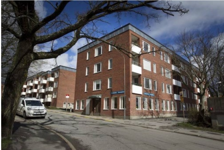
Den tegelröda byggnaden, ett långsmalt lamellhus i fem plan med kortsida mot Artemisgatan, har sin huvudentré vid en förskjutning i byggnadens mitt. Här anläggs mindre uteplatser på båda sidor med sittplatser och planteringar. Här är också husets trapphus med hiss beläget. Foto: Pekka Pääkkö
