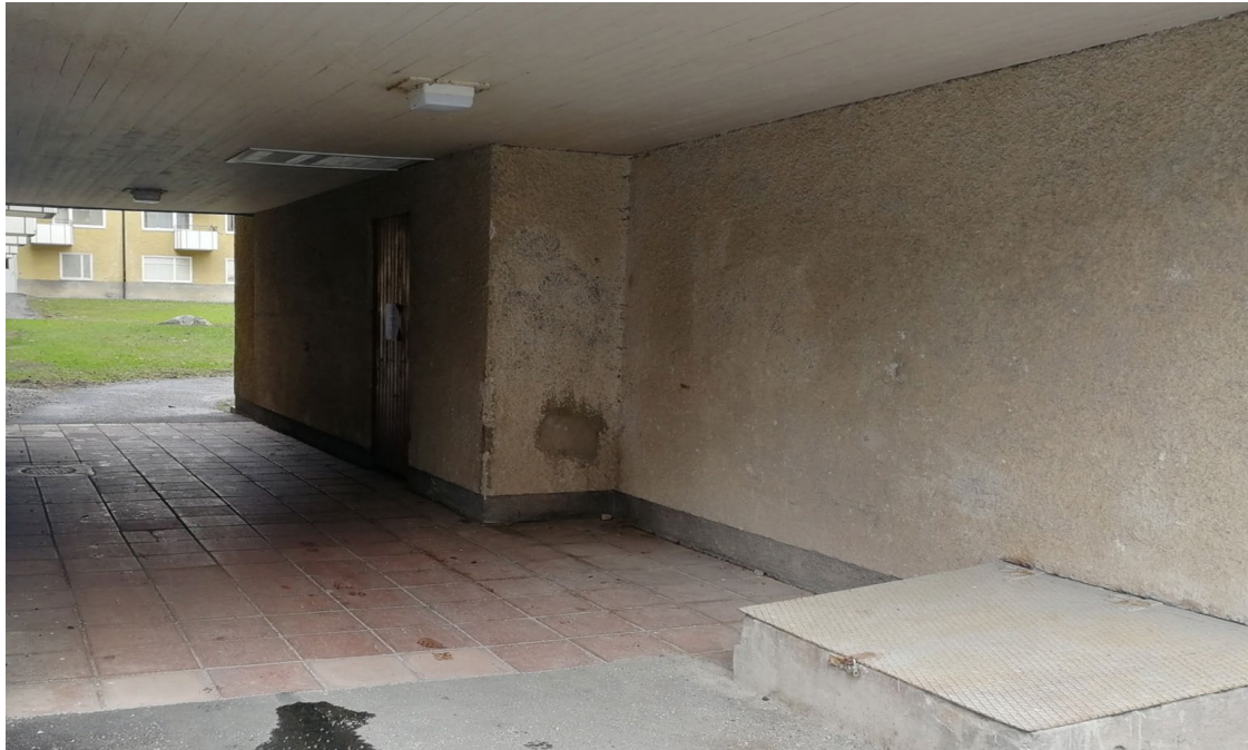
En av väggarna i gångtunneln.
