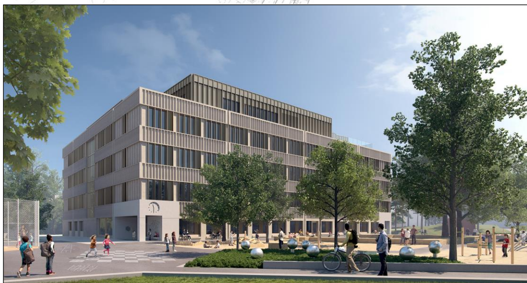
Skolans huvudentré är placerad till vänster och på höger sida syns Enbackens park. Byggnadens femte våning är en lätt konstruktion i bronsfärgad aluminium och är planerad som ett kreativt kluster med plats för alla estetiska ämnen. På taket finns även en takterrass med en pedagogisk utomhusyta. Alla fönsterpartier omges av djupa reliefprofiler i aluminium som, förutom att vara en estetisk detalj, även fungerar som visst solskydd. Illustration: Tengbom.
