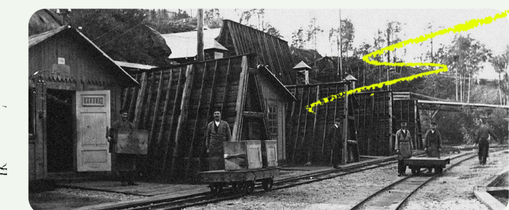
ARBETARE VID RÄLSTRANSPORT OCH PRESSHÖODOR LÄNGS DEN S.K. DJÄVULSIDDEN, 1914 Palissaderna mellan varje presshus byggdes för att undvika att fler människor än de som befann sig i det exploderande huset omkring eller att de kringliggande arbetsplatserna skadades vid en eventuell explosion.
