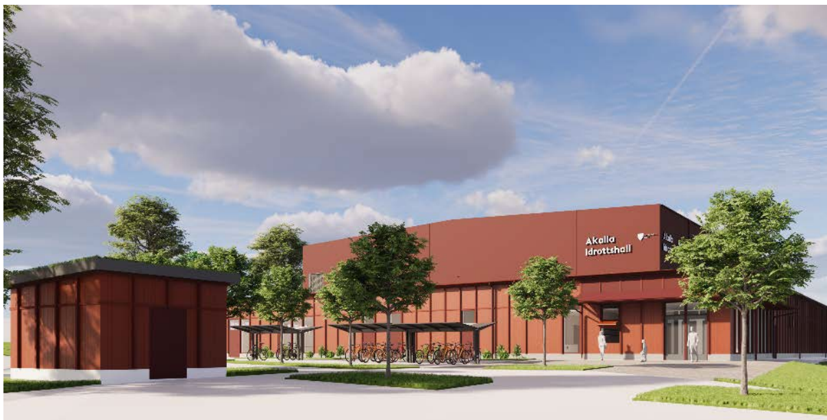
Entrén till Akallahallen. Bild: Arcana arkitekter.
